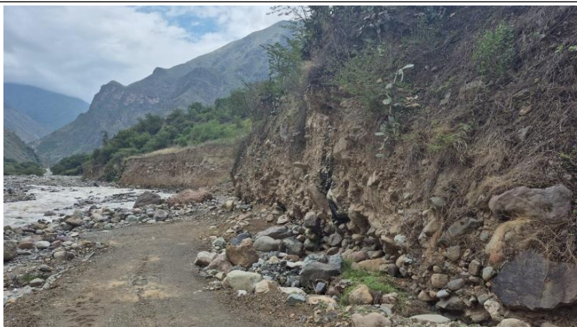
FOTOGRAFIA N°02: TRAMO CRÍTICO EN EL RÍO CHIRIS, ENCONTRANDOSE SOCAVADO Y CON EROSION LATERAL EN LA MARGEN IZQUIERDA.
