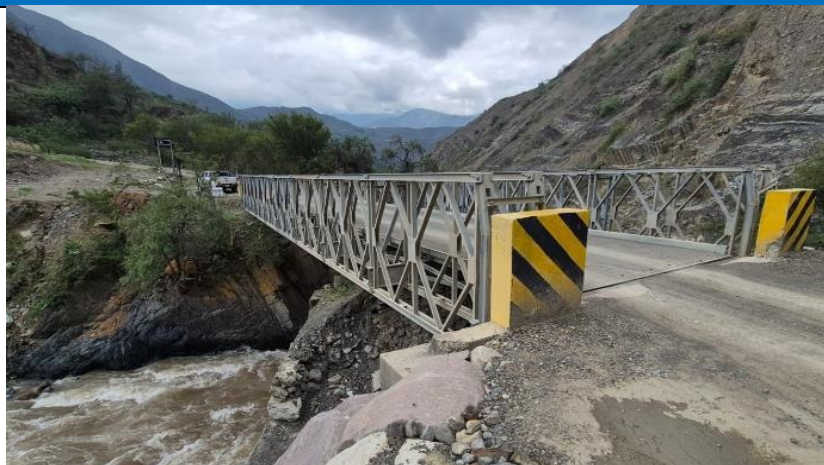
FOTOGRAFIA N°01: TRAMO CRÍTICO EN EL RÍO CHIRIS, EL TALUD DEL PUENTE LARANO SE ENCUENTRA SOCAVADO.
